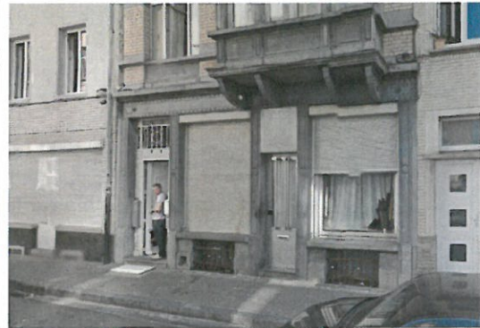
Poutre séparant le RDC des étages supérieurs (Google Street View)
